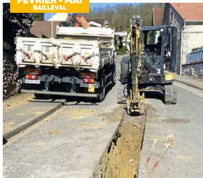
Rue aux Dames et Rue Hôtel Guehain - Renouvellement des canalisations et des branchements d'eau potable.
